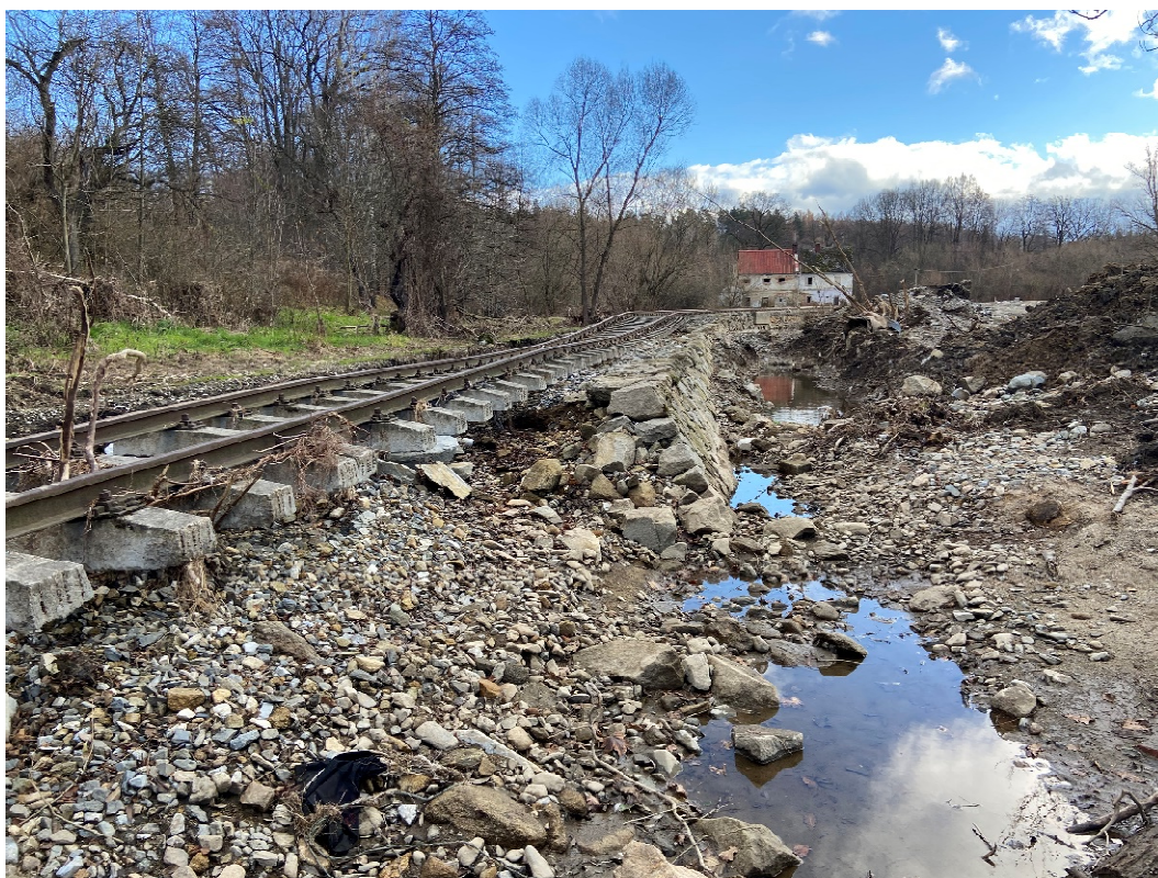
Obrázek 6 - poškozený násep, Kobylá nad Vidnávkou 09/2024
